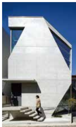
シラスコンクリートでできた住宅
