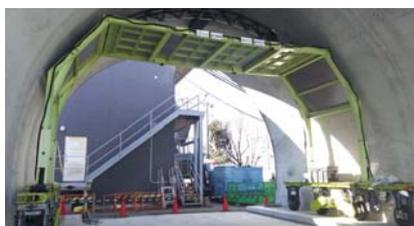
図2:上部のモジュールで打音検査をしながらトンネルを進むロボット。トンネル側面でのみ作業を行うため、交通規制を伴わない。
