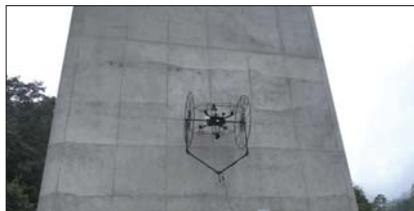
図1:高さ30m以上の橋を精密に制御されたドローンが点検していく様子。従来、高所作業車などを使って作業員が検査していた。
