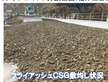
フライアッシュ CSG 打設位置(堤体上部断面)
