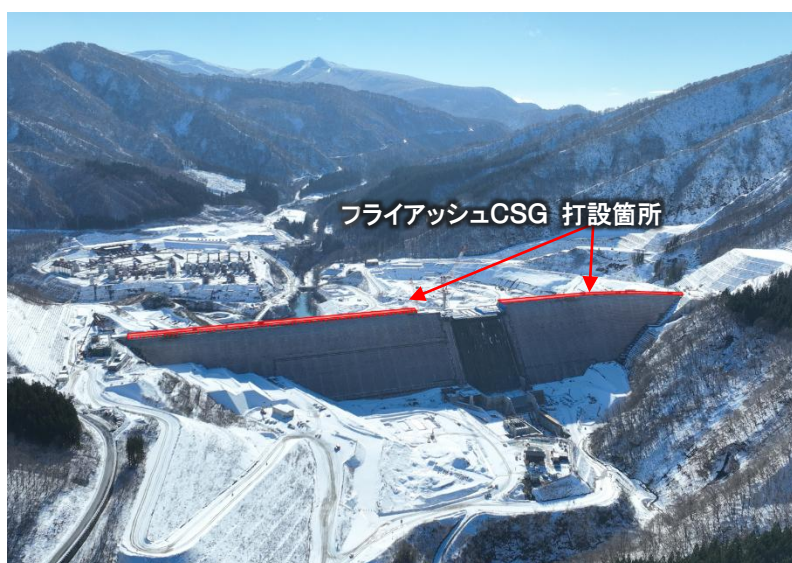
成瀬ダム堤体の一部に導入したフライアッシュ CSG
