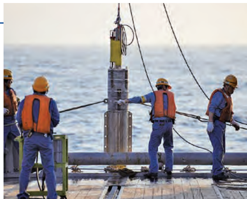
南鳥島レアアース泥のピストンコアラーによる探査
