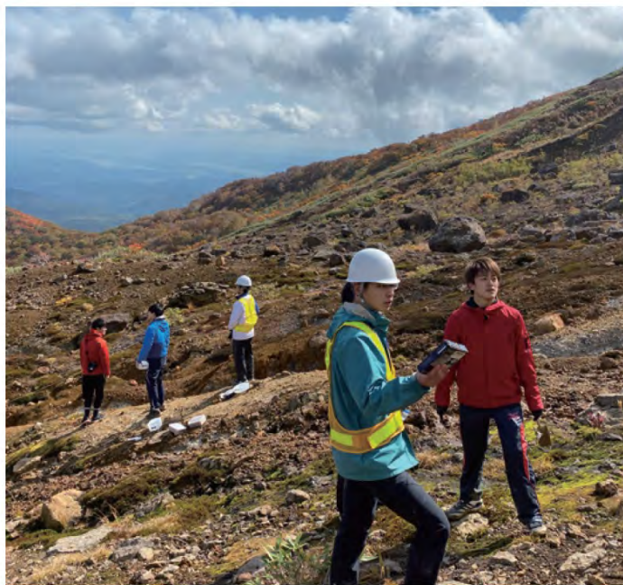
斜面崩壊現場視察(栗駒山)
