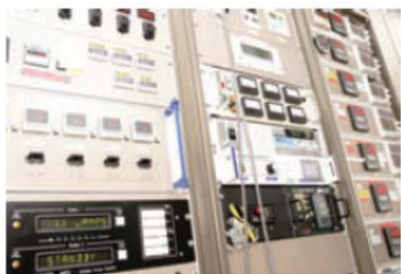
真空装置コントローラー
