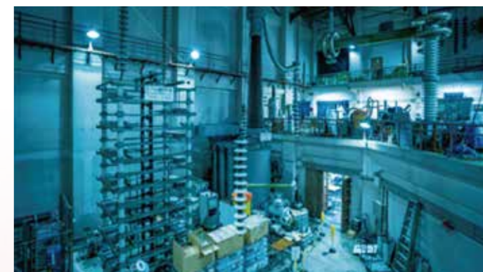
▲研究室ホール
