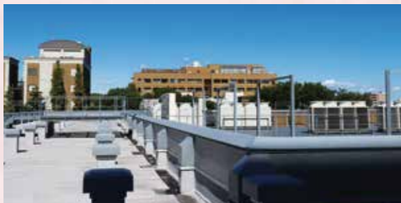
工学部4号館の屋上▶
